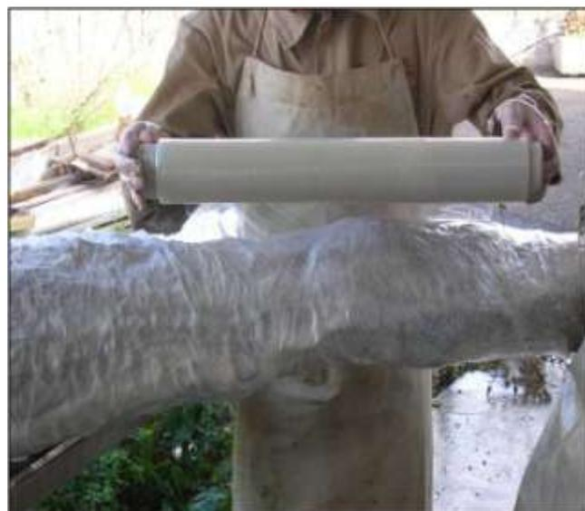
**Figura 22.** Rivestimento con pellicola di cellophan dello stesso elemento ligneo
