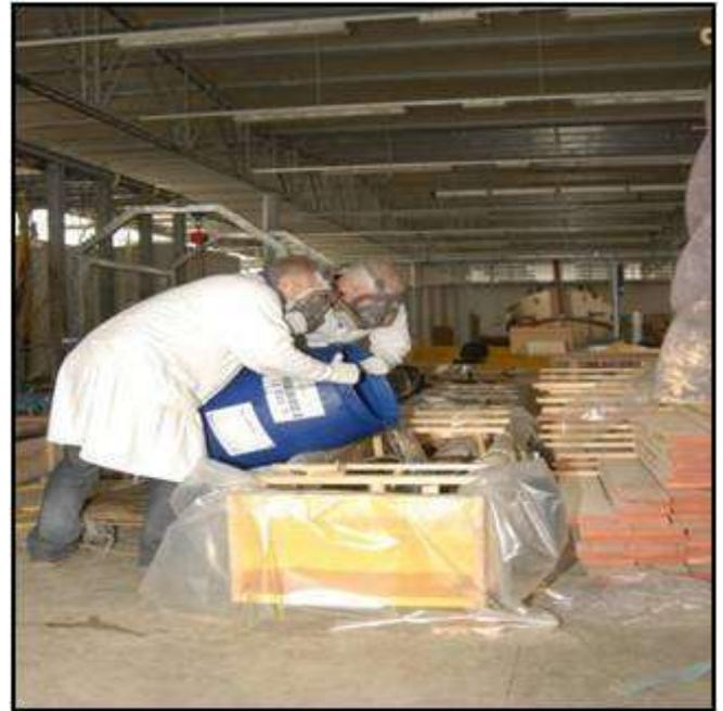
**Figura 19.** *La soluzione viene versata nelle vasche appositamente predisposte per il trattamento*
