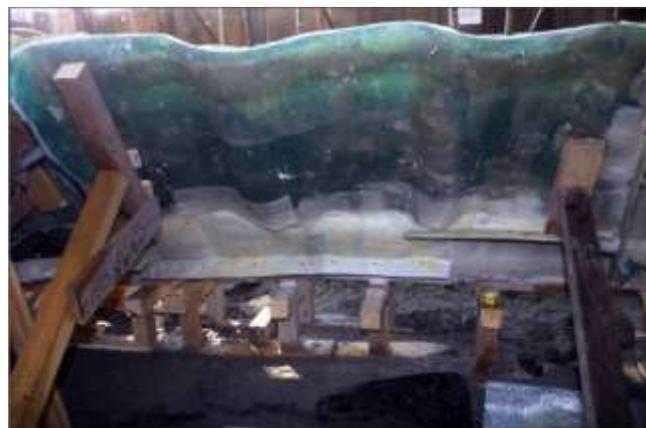
**Figura 3.** Realizzazione del guscio protettivo in vetroresina
